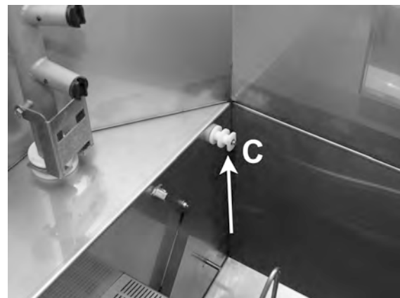
Photo 26 Capteur de niveau
